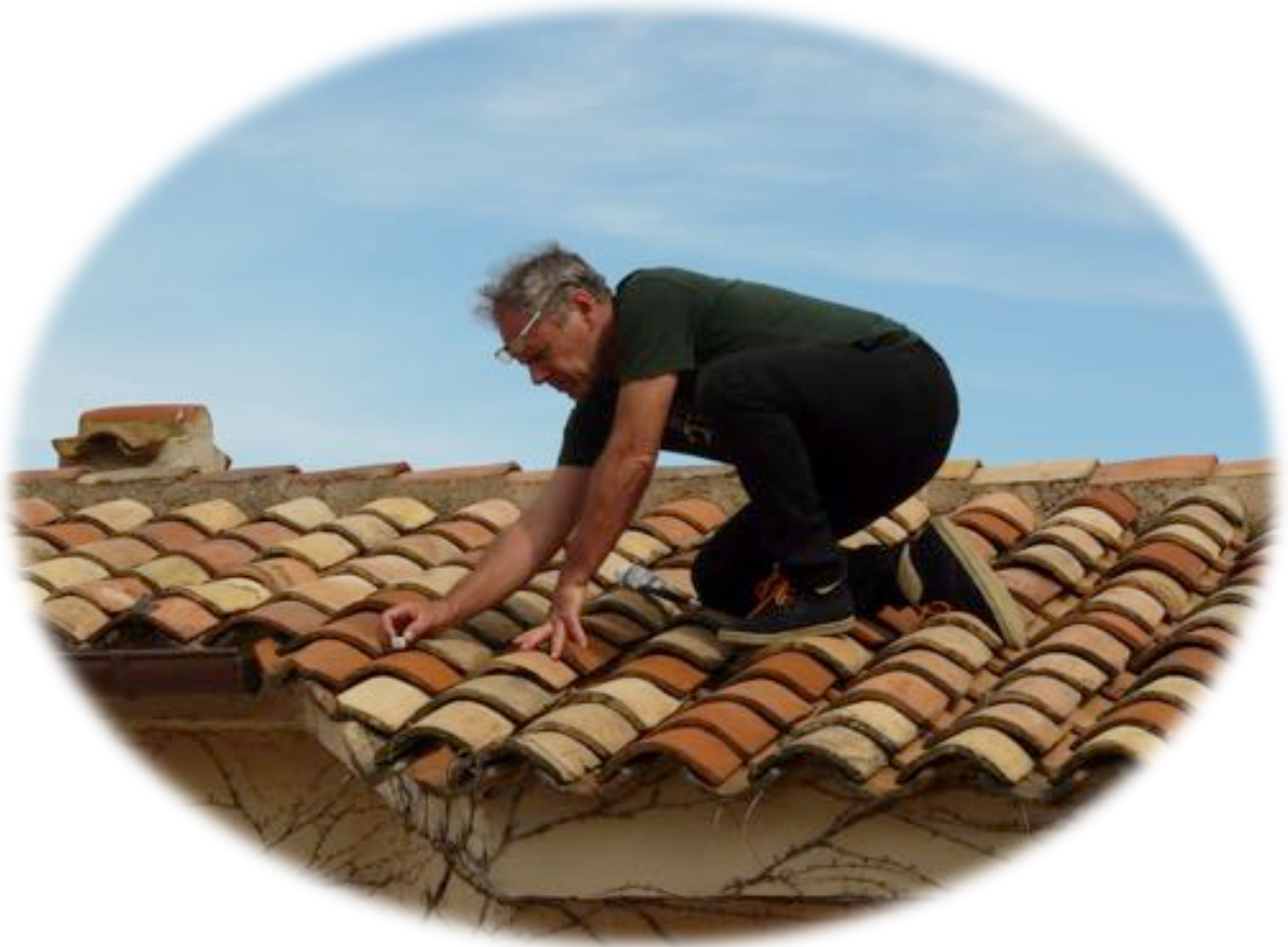
Correction d'une pente de toit / Roof slope correction
